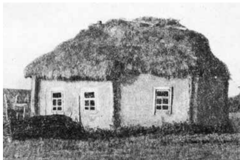
Рис. 21. Бревенчатый дом со сплошной глиняной обмазкой (с. Пичевка Пензенской области). Фото автора, 1957 г.
